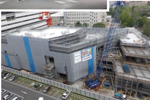
遮蔽躯体の工事が完了（2016年9月下旬撮影）
