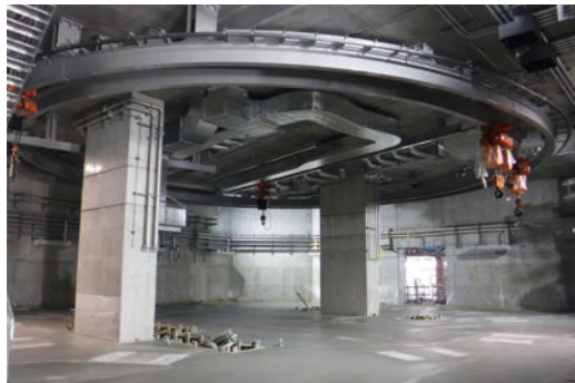
重粒子がん治療施設内観（工事中）
